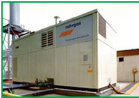
Resim 4.2 : PAFC Kullanılan Bir Elektrik Jenarötörü.
