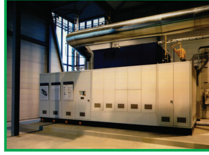
Resim 4.2 : SOFC Kullanılan Siemens Modülü
