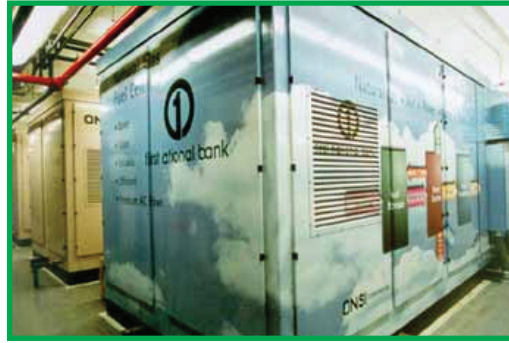
Resim 5.2 : UTC 'ye ait 200 kW değerindeki Fosforik Asit Yakıt Pili (PAFC)
